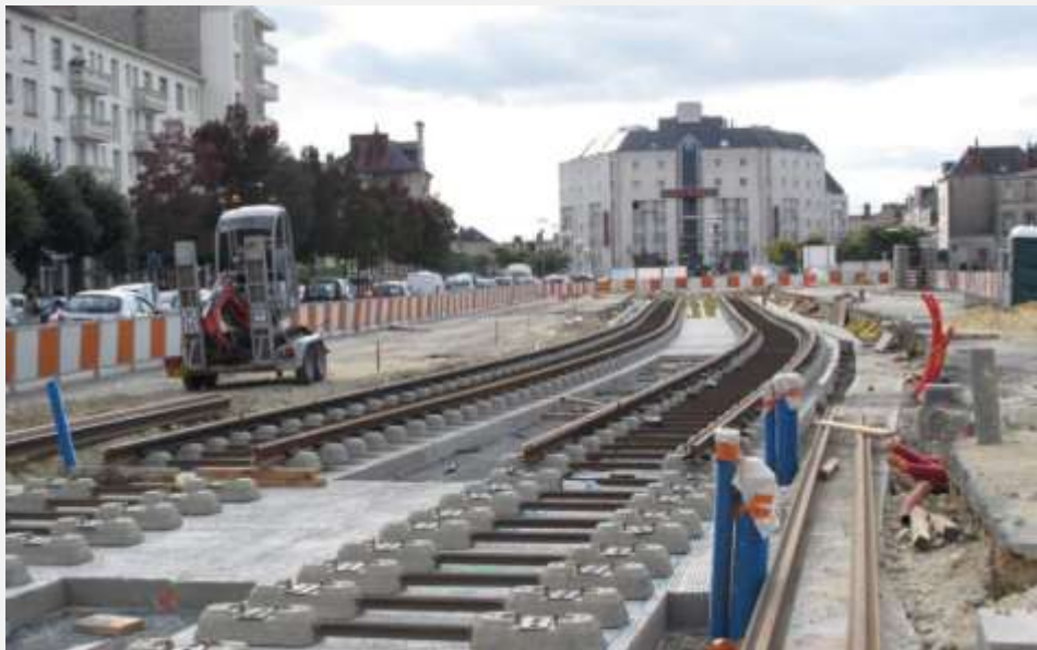
Figure 118 : Exemple de chantier de tramway de la ville de Tours
