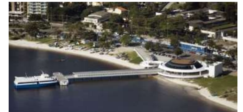
Figure 70 : Installation pour liaison maritime [9].
