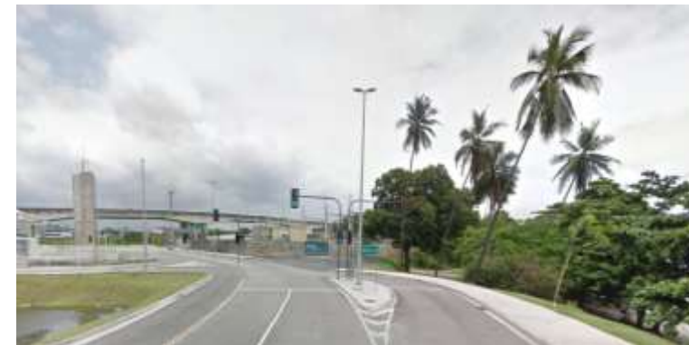
Figure 26 : Carrefour accès Terminal BRT
