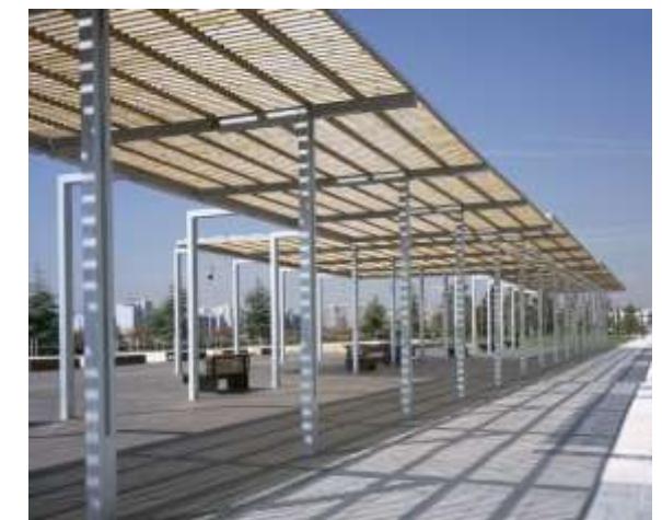
Figure 65 : Mise en place de pergolas
